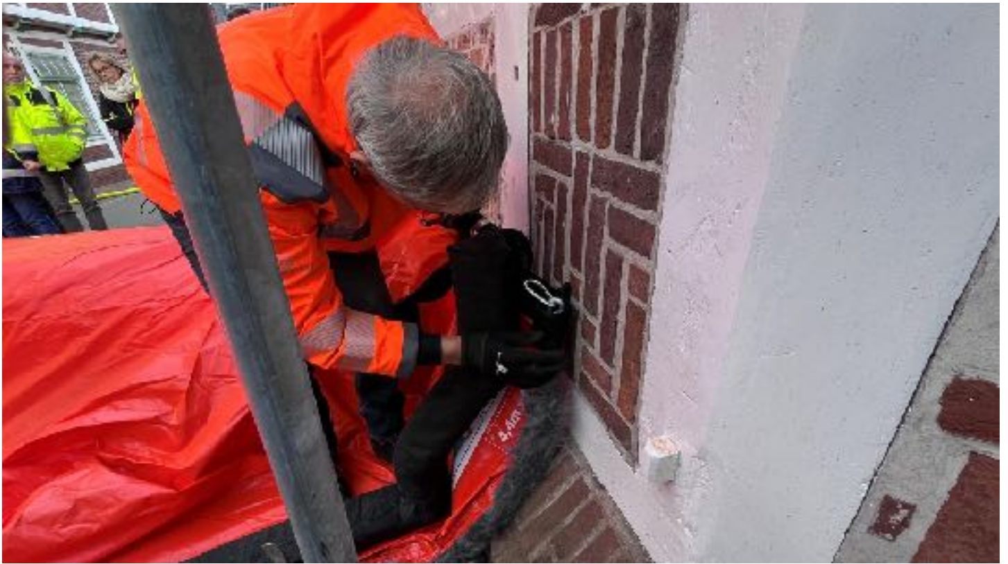
Blick auf Klemmprofil und Faserdichtung des Mobildeichs. Foto: Vasel
