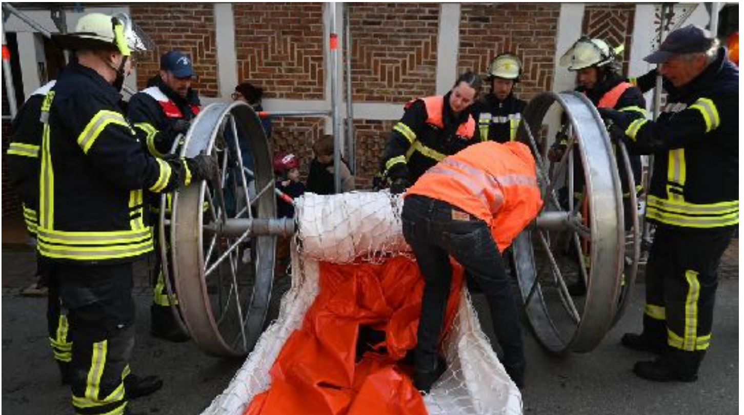
Der Mobildeich wird auf einer Rolle transportiert. Foto: Vasel
